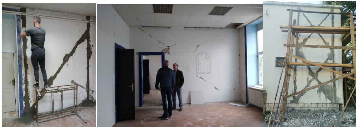
Си.7. Сеизмички појачана два објекта у Хрцеговини. Освојена технологија производње уређаја ДЦ90 и извођење радова. Корисник је оспособљен да може самостално да користи технологију
